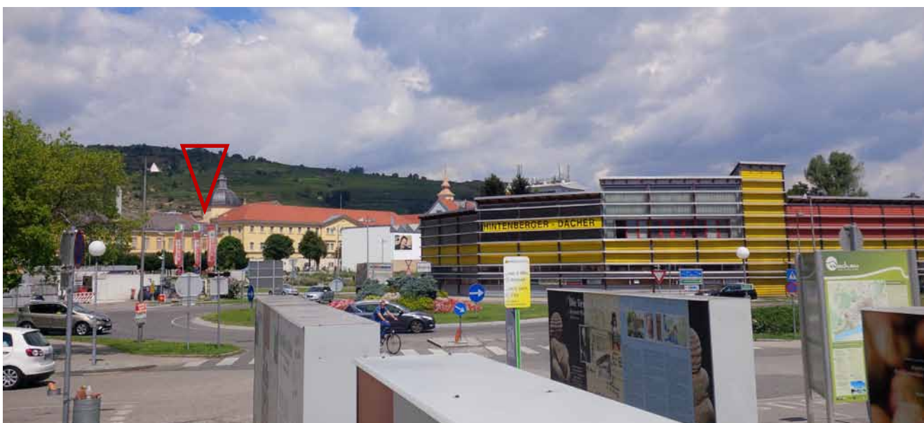
Abb. 5.17 a, b, c: Oben: Blick vom Bereich der Donau zum Franz-Zeller-Platz um 1930 und bis zum Abriss der dort errichteten Tankstelle im Jahr 2001. Unten: Heutiger Blick von der Schiffsanlegestelle Krems-Stein in Richtung Franz-Zeller-Platz. Das Projektgebiet ist jeweils mit einem roten Pfeil gekennzeichnet. (© Ing. Martin Maurer)
