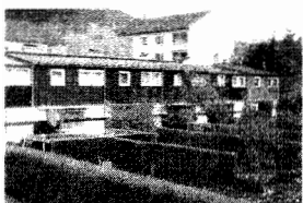
Reihenhauszeile mit davor liegenden Garagen und Schuppen
