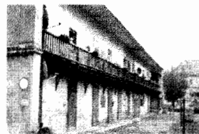
noch nicht saniertes Wohnhaus
