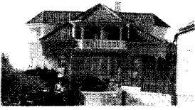
Einfamilienhaus als Repräsentationsobjekt im Weinviertel
