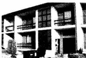
Kl. Tullnerbachgasse, individuelle Fassaden
