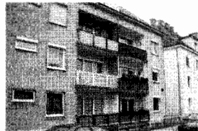
Balkon vor der Fassade Hainburg
