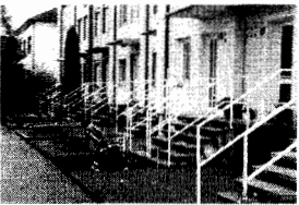
Fassade zum Hauptplatz
