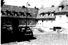
Reihenhäuser mit Vorgärten in der Hoys Straße
