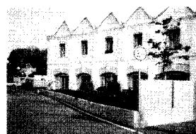
ehemalige Fabrikhalle in Lichtenwörth, die zu Wohnzwecken umgebaut wurde
